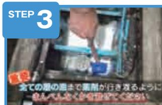
洗浄液(STEP1)をグリストラップ全体にバランスよく投入する。次に、洗剤液が隅々まで行き渡るように全層をしっかりとかき混ぜる。
